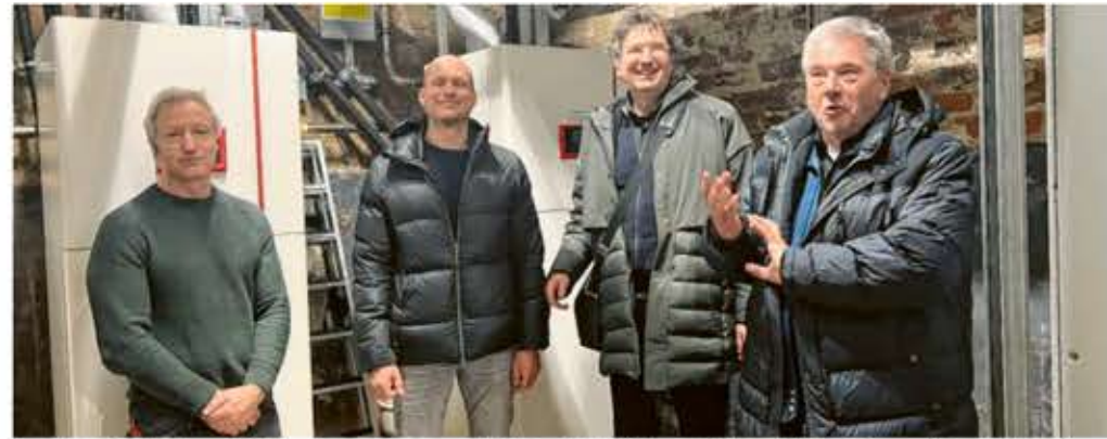
Anastasios Niokos, Gebäudemanagement, Oliver Schmitz und Bernd Wenninger, Staatliches Bauamt Krumbach, und Dietmar Heil von Inutec, Ulm (von links), erläutern die Technik. Foto: Werner Martin
